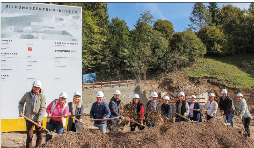
Großaufgebot beim Spatenstich des Bildungszentrums. ÖBA Martin Juffinger, Bgm.-Stv. Marissa Dünser, Hortleiterin Katharina Gasser, Hans Feller als Vertreter der Firma Ing. Hans Bodner Baugesellschaft m.b.H & Co. KG, Architekt Armin Pedevilla, Landesrätin Astrid Mair, Bgm. Reinhold Flörl, Architektin Johanna Herzog, Kindergartenleiterin Martina Gassner, Bildungsreferentin GR Gabriele Pertl, Kinderkrippenleiterin Monika Aschenwald, VS-Direktor Stefan Wieser und Waltraud Schermer (v. l. n. r.).
